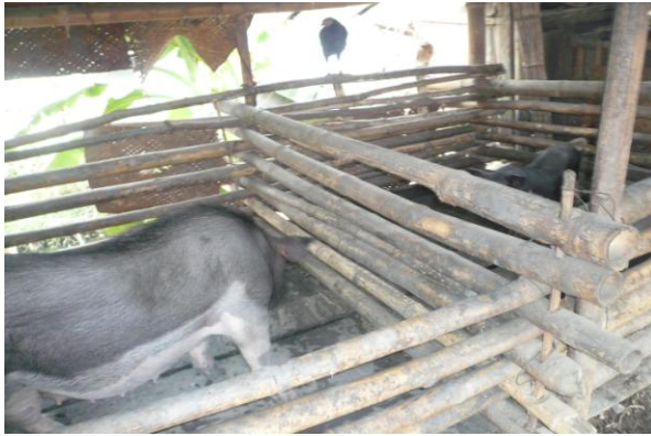
Chuồng lợn nái cổ truyền với diện tích hẹp và không được che chắn tốt
