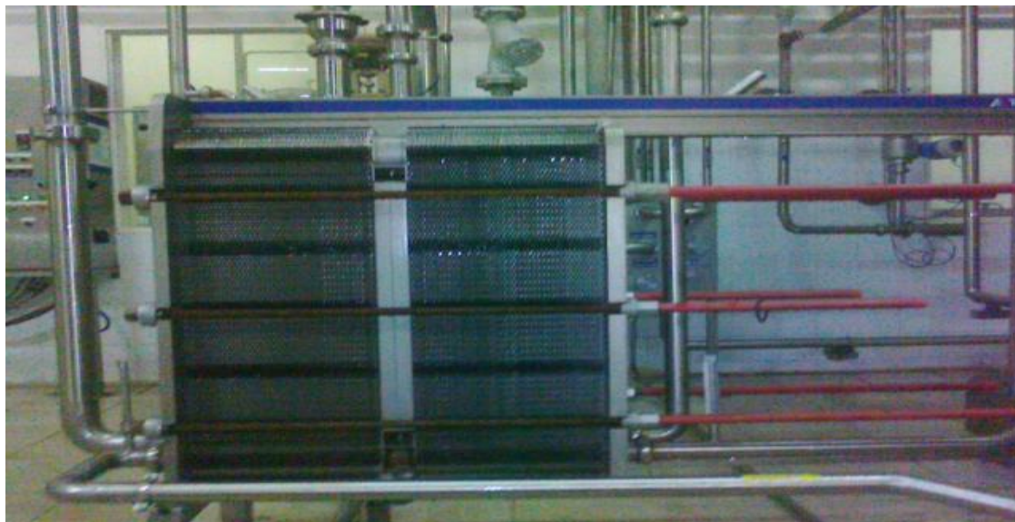
Hình 3.14. Thiết bị trao đổi nhiệt khung bản
