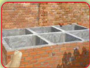
Bước 1: Chuẩn bị hố ủ Hố được xây bằng gạch và xi măng. Kích thước hố: 1 x 1 x 1m (ủ được
